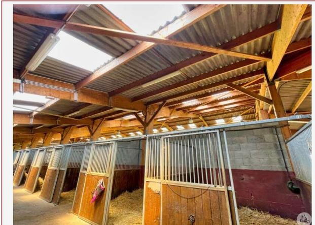
La charpente est en lamellé collée.
